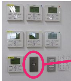
画像 4 廊下側壁面
