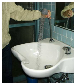
緊急シャワー （トイレに設置）
